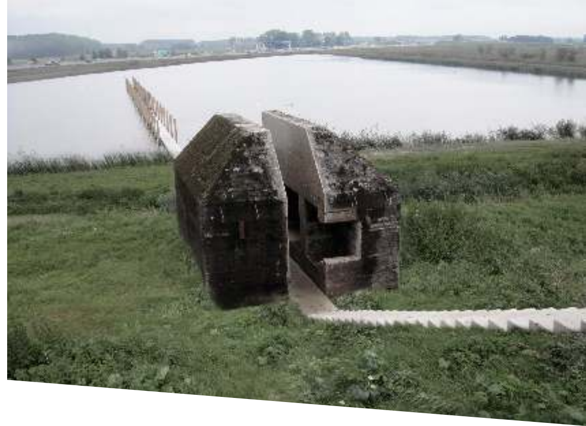
Bunker 599, RAAAF en Atelier de Lyon (2013)
